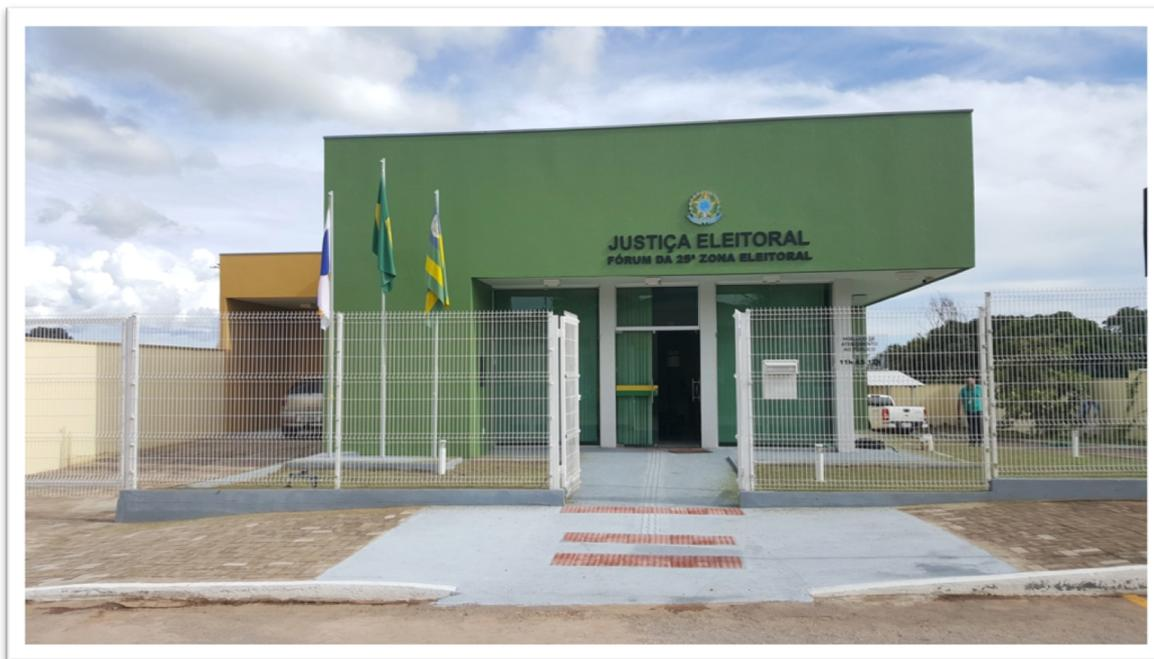
Foto: Dianópolis - Adequação da rampa de acesso com eliminação de irregularidades no piso e instalação de piso tátil.
