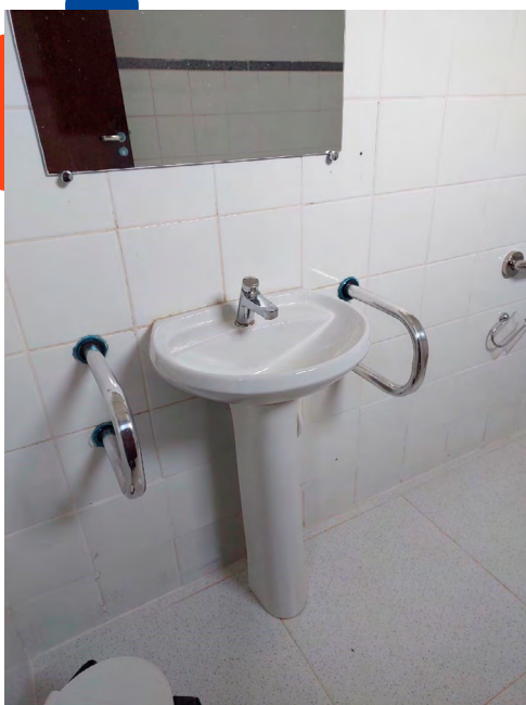
Instalação de barras de apoio nos lavatórios dos banheiros públicos
