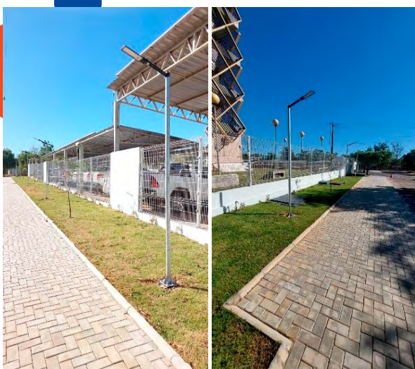
Execução de nova calçada pública com iluminação
