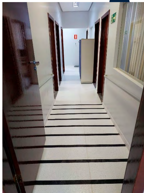
Instalação de faixas antiderrapantes no corredor interno (inclinado)
