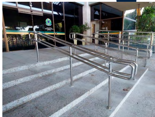
Instalação de corrimão intermediário na escada da entrada principal
